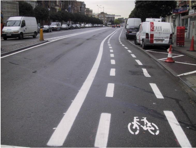
Figure 17 Piste cyclable marquée avec marquage du bord de la chaussée, à côté de la piste
